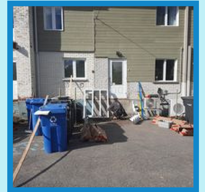
Remplacement des balcons
